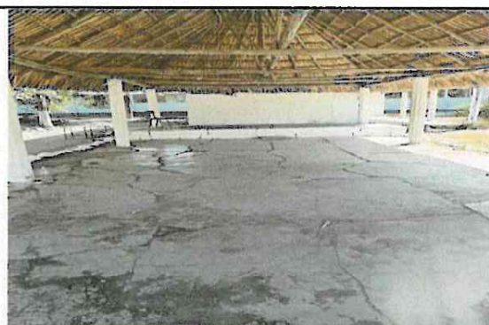
Sustitución de soporte de madera por metal y sustitucion de palma por lamina troquelada.
