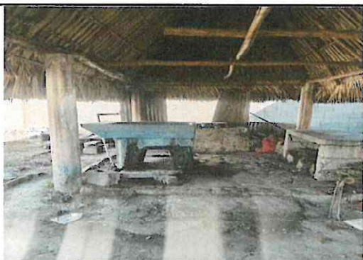
sustitución de estructura de soporte de madera por metal en cocina ya que sufre daños y se puede producir un colapso, sustitucion de pila, y reparación de torta de concreto.
