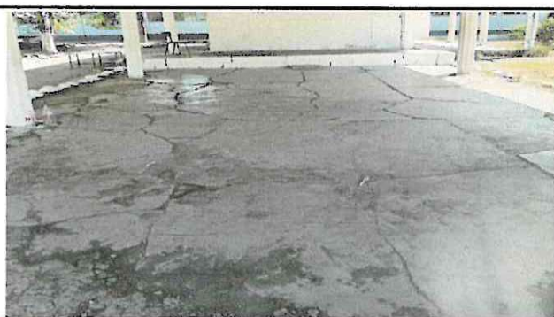
Reparación de torta de concreto por daños de grietas.
