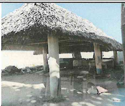
Sustitución de palma por lamina troquelada en area de cocina por daños y filtración de agua.
